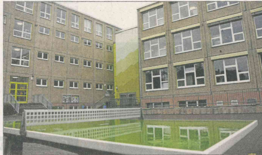
Das Gebäude in der Wilhelm-Bock-Straße, in der sich zurzeit noch Hansen-Grundschule und ein Teil des Förderzentrums befinden, soll vom Landkreis an die Stadt Gotha übertragen werden, wenn das Förderzentrum nächstes Jahr auszieht. Foto: Claudia Klinger
